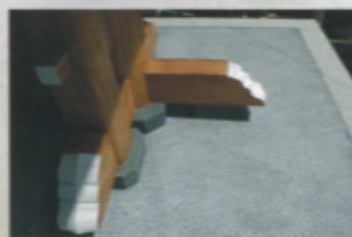
正樹院鐘樓の地覆木鼻
