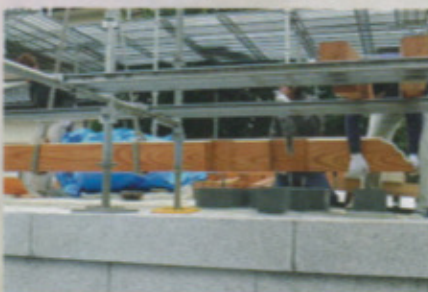
建て方（木工事開始）
