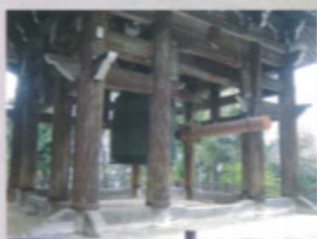
知恩院鐘樓堂桁下の構造
